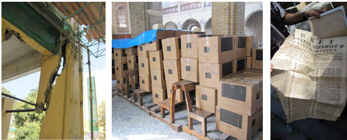
A gauche : un pilier du bâtiment qui abrite la BHPSE. Au centre : le stockage des ouvrages sous bâche dans l'église du séminaire qui a perdu une partie de son toit. A droite : Un exemple de document original
